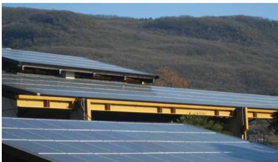
LA STRUTTURA FOTOVOLTAICA, REALIZZATA CON 212 MODULI AD ALTA QUALITÀ CANADIAN SOLAR, SODDISFA L'INTERO FABBISOGNO ENERGETICO DEL RISTORANTE
