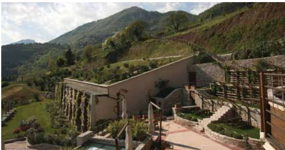
I TETTI DELLE UNITÀ CHE COMPONGONO LA STRUTTURA SONO RICOPERTI DI VEGETAZIONE PER UNA PERFETTA INTEGRAZIONE CON LA NATURA CIRCOSTANTE
