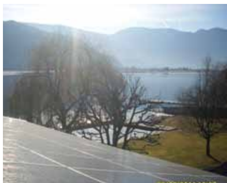
L'IMPIANTO DI ON ENERGY È INSTALLATO SULLE DIVERSE FALDE DEL TETTO, CHE PRESENTA INCLINAZIONE E ORIENTAMENTO OTTIMALI PER LA PRODUZIONE DI ENERGIA SOLARE
