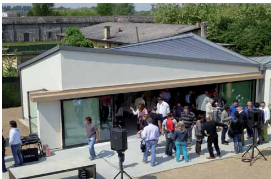
L'IMPIANTO FOTOVOLTAICO, REALIZZATO DA PREFALZ, È COSTITUITO DA 14 MODULI FLESSIBILI IN SILICIO AMORFO, CON UNA POTENZA DI PICCO TOTALE DI 1,9 KWP
