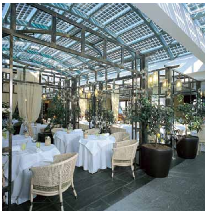
L'IMPIANTO FV INTEGRATO SULLA COPERTURA DELLA SALA DA PRANZO È COSTITUITO DA 69 MODULI ERTEX SOLAR COLLEGATI A 3 INVERTER SMA
